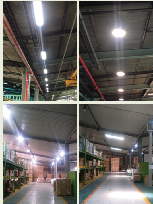
LED 교체 및 채광창 적용 현장
